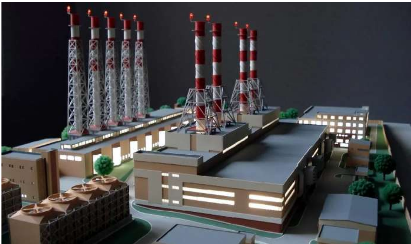
Рис. 2 ПГУ-ТЭС 260 МВт "Строгино" является первой ПГУ-ТЭС
