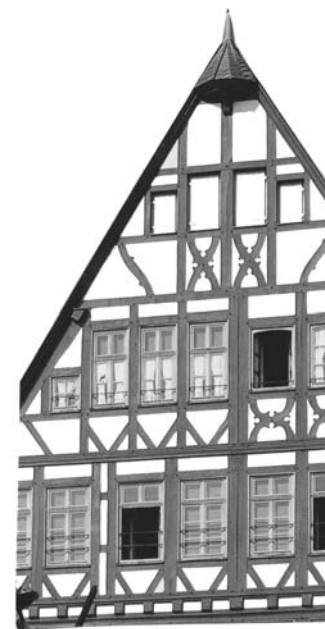
Рис. 21. Общий вид фрагмента фасада двухэтажного жилого дома с выступающим деревянным каркасом – фахверковым.
